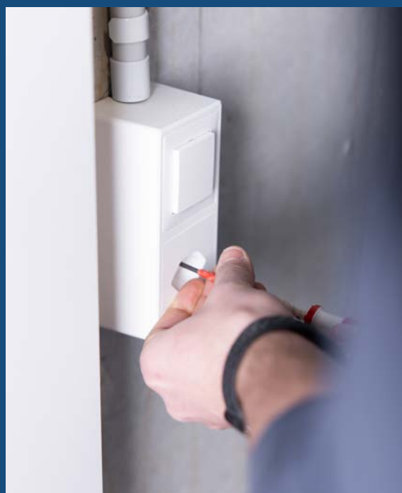
Als Elektroinstallateur ist Fingerspitzengefühl gefragt.
