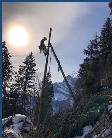
Arbeiten am Strommast Schwändiberg, Braunwald (links).
