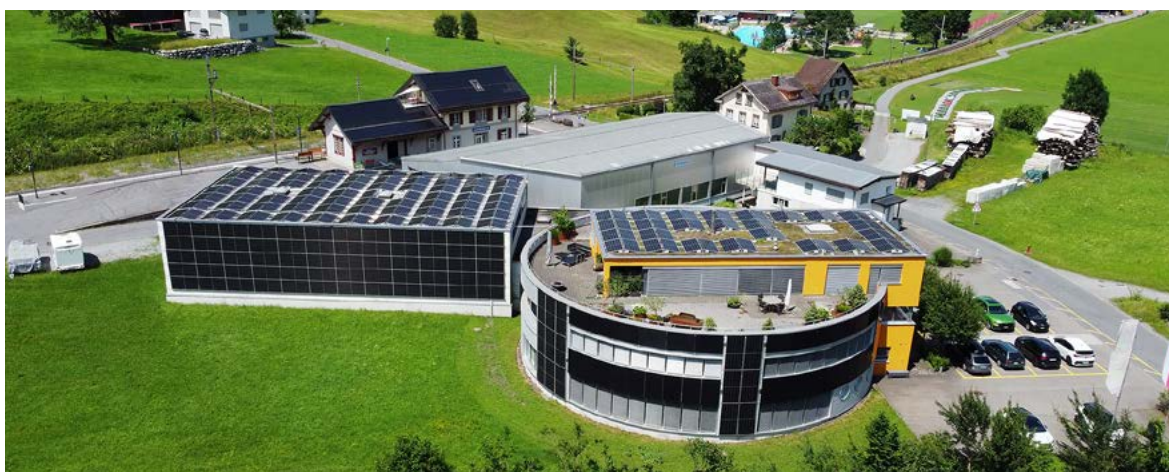
Drohenaufnahmen der Flachdach- und Fassadenanlage.
